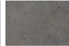
İNCE BETON DOKU
