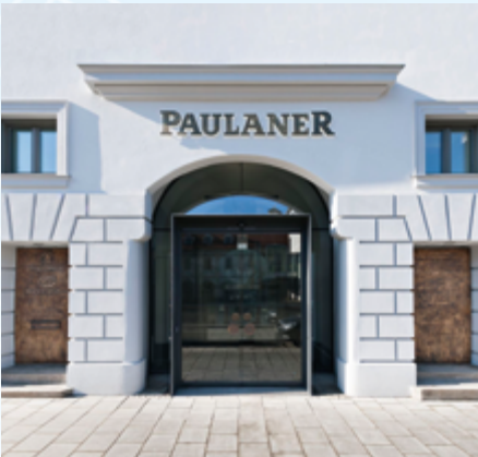
Tarihi Yapı Restorasyonu Paulaner Brewery - Münih, Almanya
