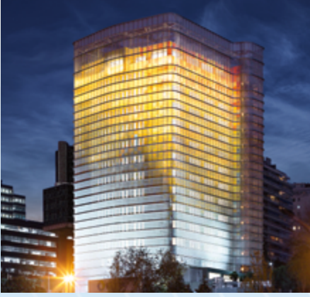
Isı Yalıtımı Renovasyonu Torre 30 - Madrid, İspanya
